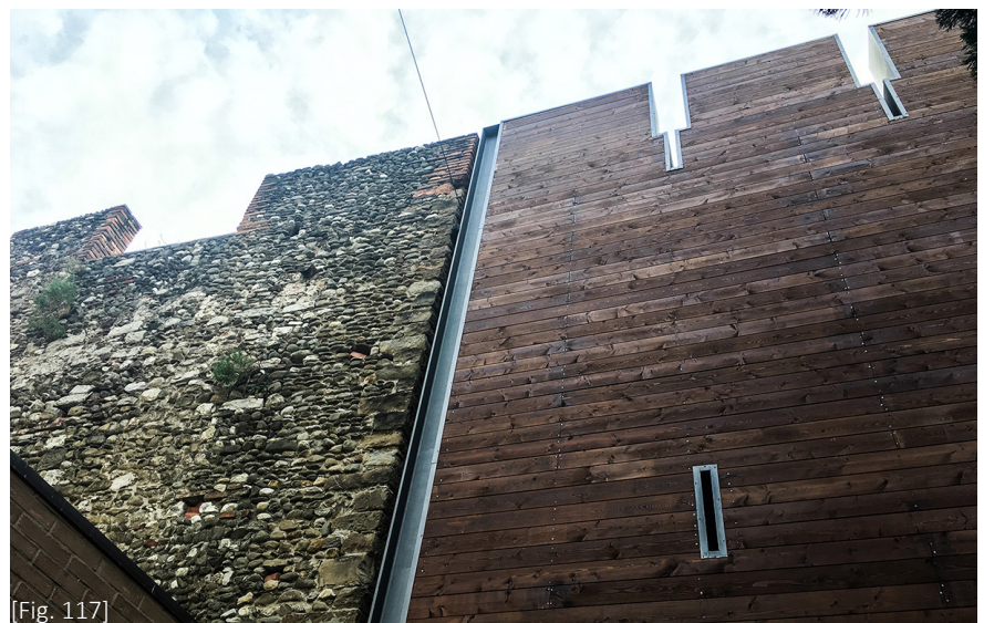
[Fig 117] Junta de separación entre la antigua muralla y la nueva (Pola, F. (2013): Il corridore di Prato )
