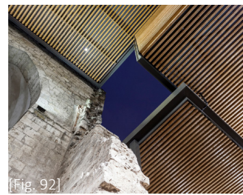
[Fig. 92] Encuentro de la cubierta con el muro existente (Manuel Barrio, J. Sainz de Aja, A. [2018]: "Nueva cubierta para el monasterio de San Juan [Burgos]", Revista ph , nº93 pp.72-95)
