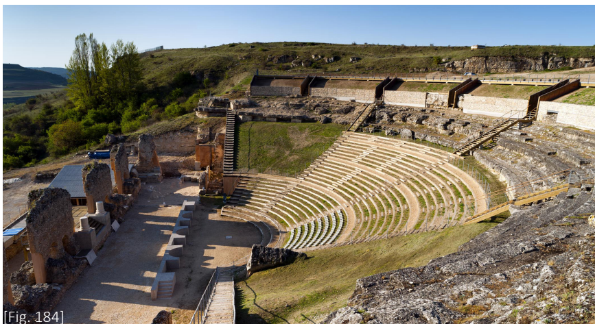
[Fig. 184] Se construyó una pasarela como remate, se reconstruyó los cunéis de la cávea superior y se reproduce parte del graderío (Imagen facilitada por los arquitectos)
