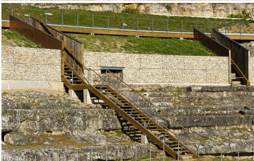
[Fig 186] Pasarela de madera sobre esperas de hormigón armado (Imagen facilitada por los arquitecto)
