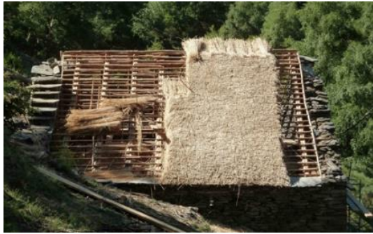
Fig. 217. Construcción de la cubierta [Josep Bunyesc]
