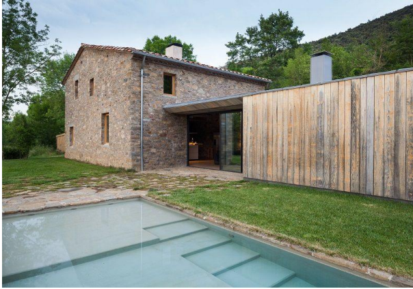
Fig. 63. Encuentro entre cubierta y fachada de los dos volúmenes y piel de madera que no toca el suelo
