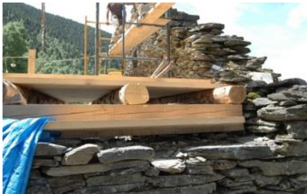
Fig. 219. Apoyo de los forjados en el refuerzo de madera sobre muro [Josep Bunyesc]
