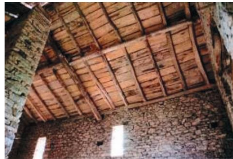
Fig. 189. Estructura original de cubierta [Josep Bunyesc, La rehabilitación energética aplicada a la masía]
