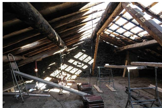
Fig. 178. Foto en obra de sustitución de la envolvente de cubierta [AcabadoMate]
