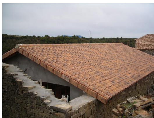
Fig. 335. Construcción de la cubierta en obra [DMP Arquitectural]
