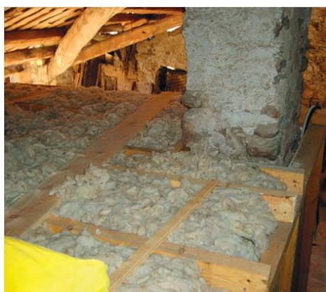
Fig. 199. Construcción de la estructura (izda.) y colocación de aislamiento (dcha.) [Josep Bunyesc, La revolución energética aplicada a la masia]
