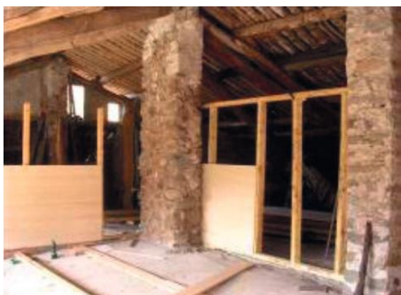
Fig. 199. Construcción de la estructura (izda.) y colocación de aislamiento (dcha.) [Josep Bunyesc, La revolución energética aplicada a la masia]
