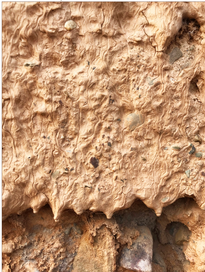
Fig. 63;4 / Fachada de adobe muy deteriorada.
