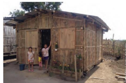
Figura 22. Tipo de vivienda construida con materiales locales, láminas de hierro y plástico. Shelter Projects 2015-2016. Pag.164.
