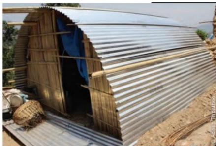
Figura 12. Refugio temporal construido por la gente con los materiales facilitados por las organizaciones. Terremoto Nepal 2015, extraída Shelter Projects 2015-2016, pag.25.
