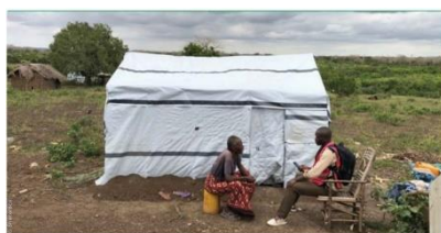
Figura 39. Refugios de emergencia, que respondían bien a la lluvia, pero pobremente contra el calor y las temperaturas frías. Shelter Projects 2017-2018. Pag.16.
