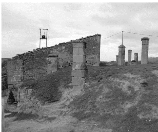
2.9. Tuferas de chimenea realizadas en sillería de piedra.
