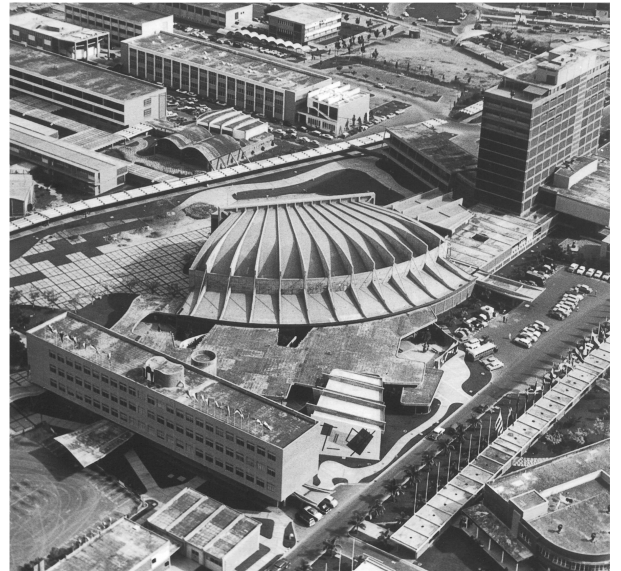
Fig. 45. Vista aérea del Conjunto Central.
