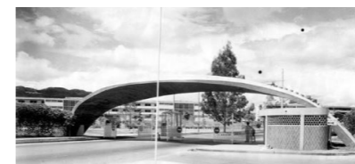
Fig. 87. Concha de Acceso. Puerta Tamanaco
