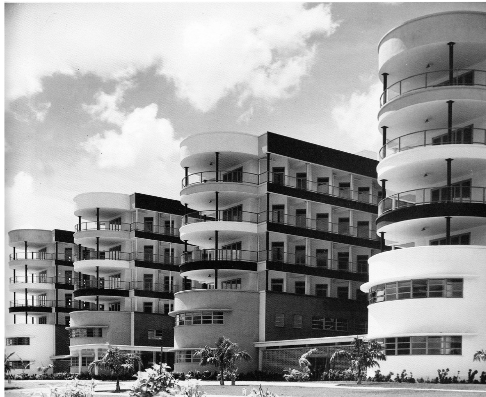
Vista Hospital Clínico
