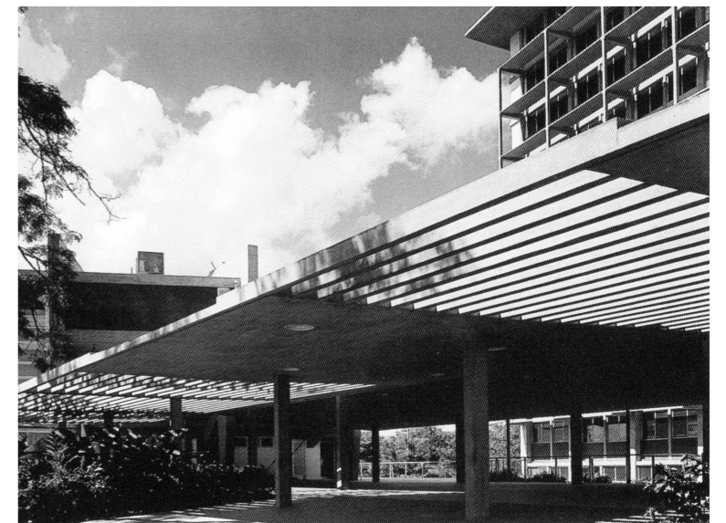
Detalles Fachada Este Villanueva, P. Pinto, M. gasparini et al. Carlos Raúl Villanueva.
