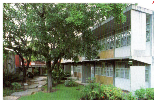
Fig. 118. Patio interior Humanidades
