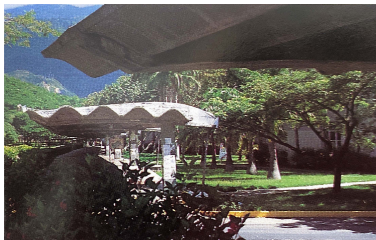
Fig. 81. Pasillo de Humanidades e Ingeniería.
