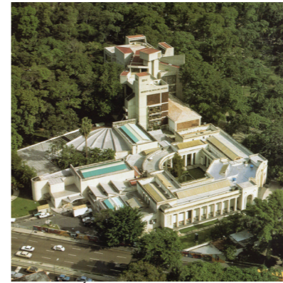
Fig. 22. Área después de la segunda ampliación.
