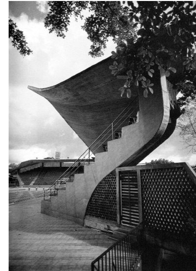
Fig. 92. Detalle Viga-pilar
