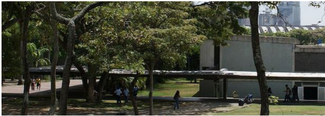
Fig. 122. Vista Facultad de Humanidades y Pasillo cubierto desde la Plaza Cubierta
