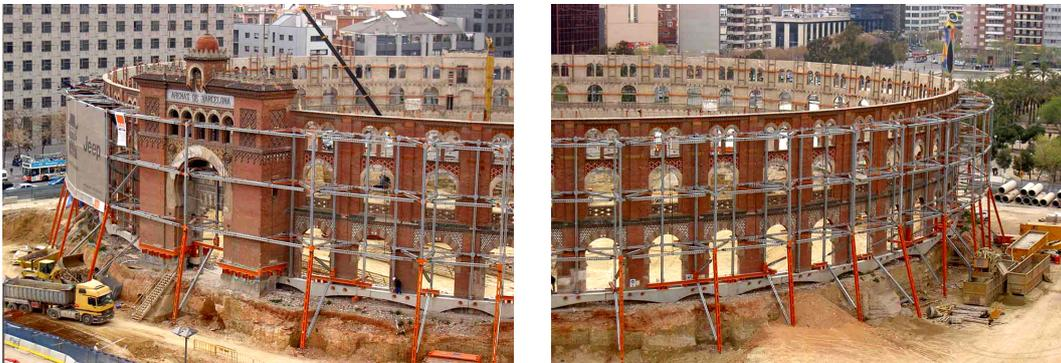
Fig 4.1.12. Imagen del vaciado de la Plaza de Toros de Las Arenas de Barcelona y sustento de la fachada neomodéjar durante las obras de restauración.
