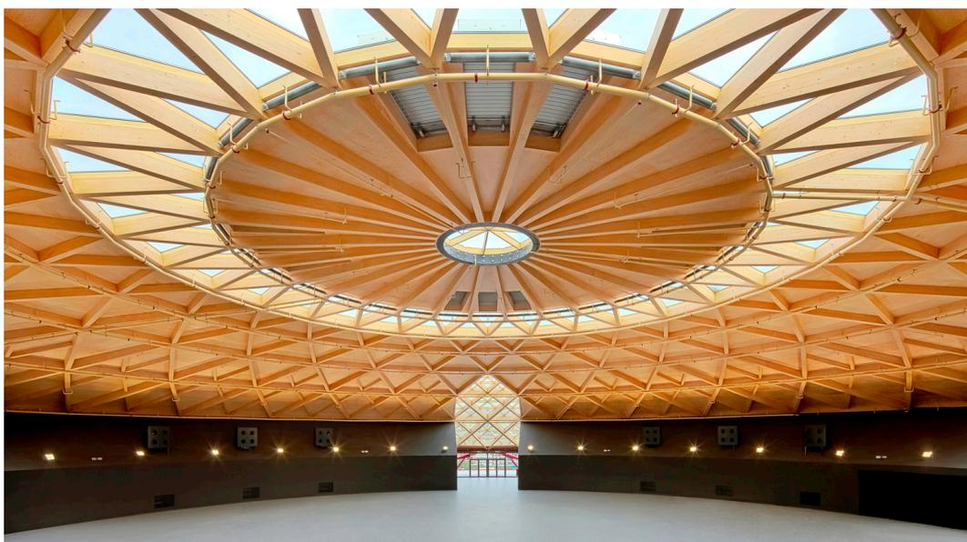
Fig 4.1.15. Imagen del interior del centro comercial Las Arenas de Barcelona, donde se aprecia la sala multiusos de la última planta, bajo la gran cúpula de madera laminada.
