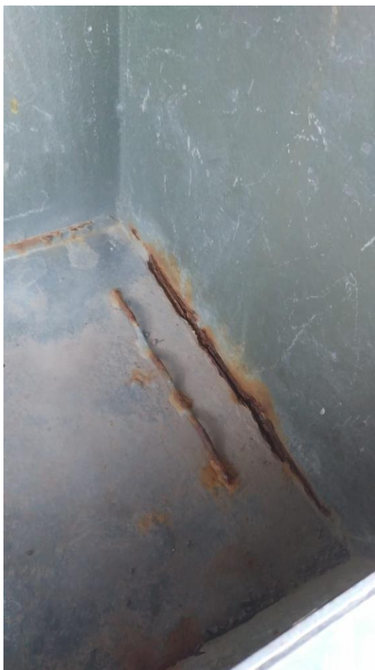
IMAGEN 16 CORROSIÓN EN UNO DE LOS CAJONES LATERALES
