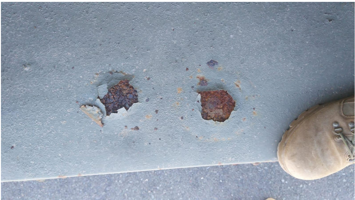
IMAGEN 17 CORROSIÓN EN SUPERFICIE EXTERIOR
