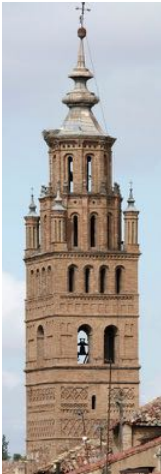
15. Vista exterior de la torre. Catedral de Santa María de la Huerta de Tarazona. Foto José Latova.
