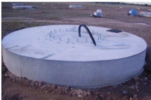
Figura 1.3 Zapata de cimentación
