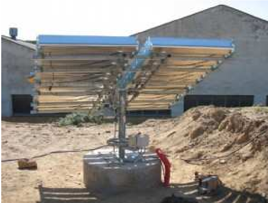
Fig 4.1. Estructura con seguidor en 2 ejes
