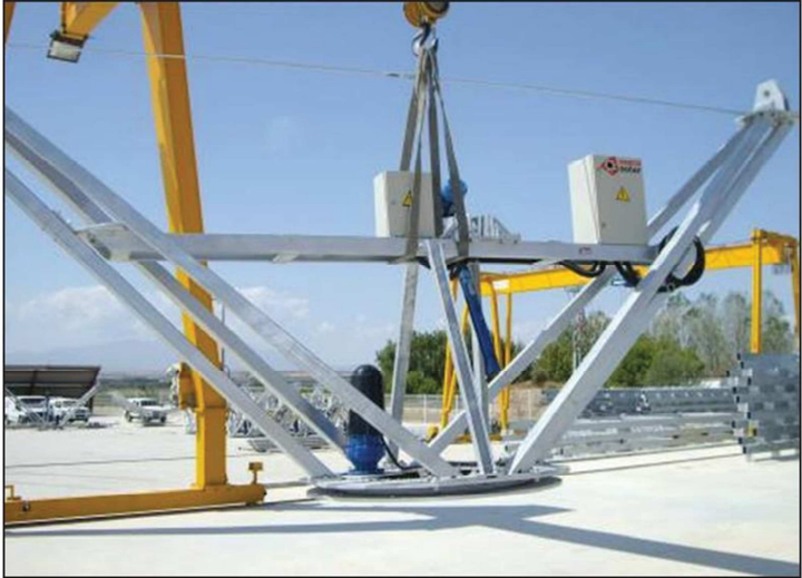
Figura 1.5 Levantamiento del seguidor
