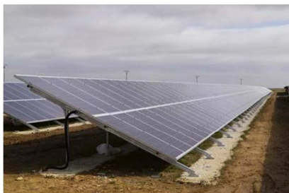
Imagen 1.3. Estructura sobre zapata de hormigón
