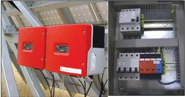
Figura 2.2 Detalle inversores y armario de acometida
