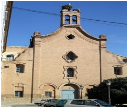
Imagen 36. Iglesia de San Juan Bautista (Alagón), Fuente: SIPCA.
