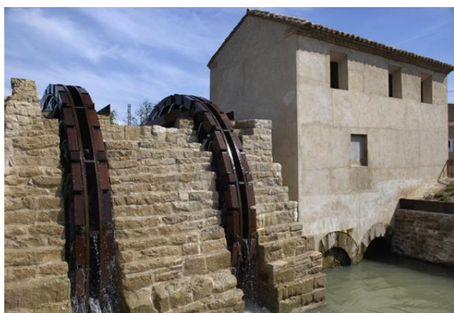
Imagen 66. Conjunto hidráulico de Velilla de Ebro, Fuente: SIPCA.
