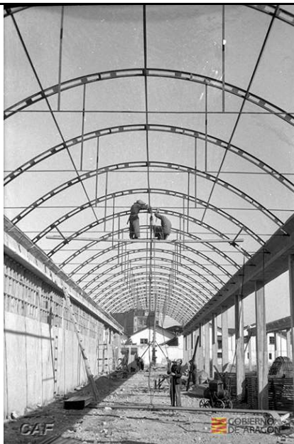
Autor Construcciones y Auxiliar de Ferrocarriles (CAF) Título VIASA, construcción naves y edificio oficinas. Cronología ca. 1959 Soporte Blanco y negro. 35 m. Negativo
