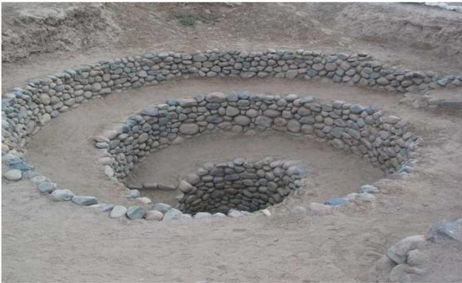
Fig. 29. *Puquio*. La cultura Nasca impulsó una sofisticada ingeniería hidráulica.
