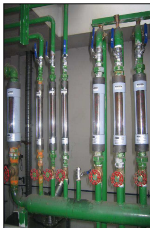
Fig. 46 Rotámetros de indicación de caudal por anillos de refrigeración [90].
