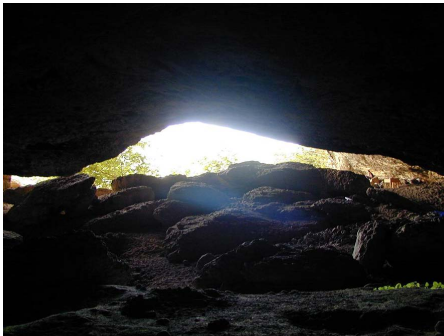
Figura 5.2 Caída de bloques en el vestíbulo de la cueva.
