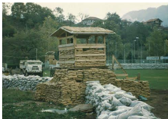
Ilustración 8. Ejemplo de torre de seguridad española construida con sacos de arena en Jablanica (Bosnia)
