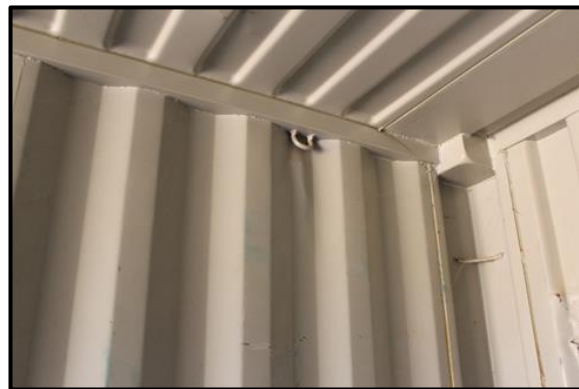
Fotografía 4. Detalle de punto de amarre dentro de un contenedor Fuente: propia
