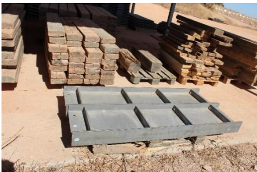
Fotografía 79. Detalle de colocación vigas de levantamiento Fuente: propia
