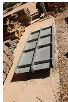
Fotografía 80. Detalle vista frontal de colocación de vigas Fuente: propia
