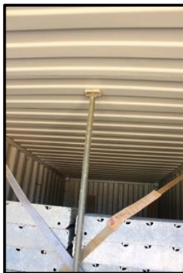
Fotografía 3. Detalle de entibado y eslingado dentro de un contenedor Fuente: propia
