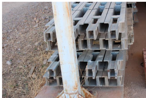
Fotografía 62. Detalle de colocación postes finales vista frontal Fuente: propia
