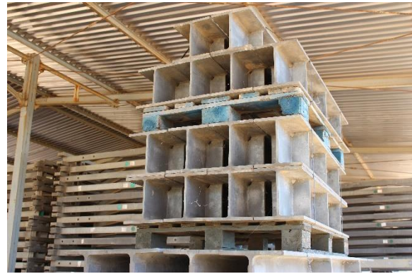
Fotografía 66. Detalle de colocación cojinetes vista frontal Fuente: propia
