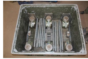
Fotografía 98. Barra trans. Travesero Fuente: propia
