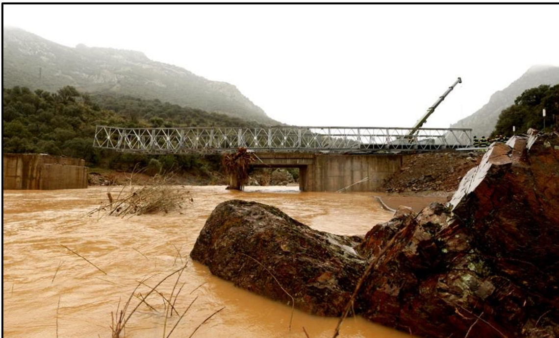
Fotografía 1. Puente Mabey sobre el río Fresneda. Montaje UME Fuente: MINISDEF
