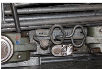
Fotografía 106. Gancho ele. tablero Fuente: propia
