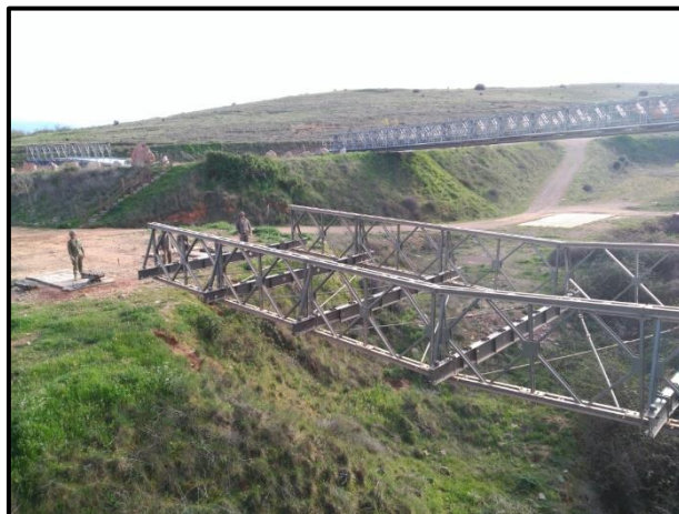
Fotografía 10. Lanzamiento puente Bailey con puente Mabey terminado aguas arriba Fuente: Brigada Ángel Martín Arevalo
