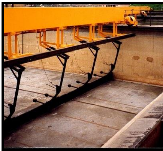
Figura 16. Decantador rectangular con raspquetas. Fuente: UPM.
