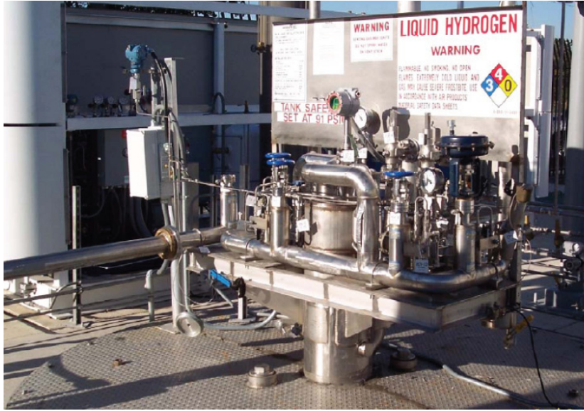
Figura 34. Almacenamiento de hidrógeno bajo tierra en estado líquido. Hidrogenera de Shell en Washington DC
