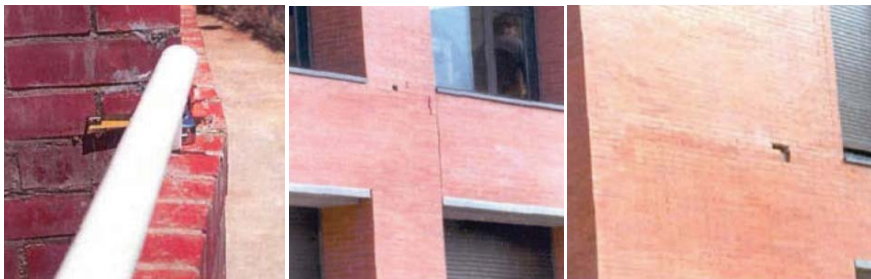
Figura II.15.- Desplazamientos, roturas, abombamientos y colapsos de fábricas sometidas a variaciones de volumen periódicas por humedad. Fuente: Isidro, 2003
