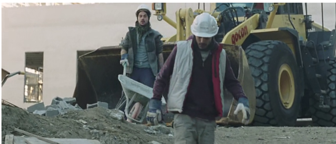
Fig. 27. Carlos y Raúl trabajan recogiendo escombros. Mediante esta profesión y el pago por la misma, Rosales edifica una de las más contundentes metáforas de la burbuja inmobiliaria y el pinchazo del ladrillo. Cada día ambos jóvenes son presa de ese dismantelamiento realista y simbólico de la falacia arquitectónica como parte del poderío económico de una sociedad que creyó en una prosperidad desproporcionada y eterna. El alto precio de las construcciones contrasta con la bajada salarial por recoger lo que quedó de ellas, y alude a otro precio intangible, el de las vidas de estos muchachos, tan desconchadas y roidas como el material en desuso que apilan a diario.
