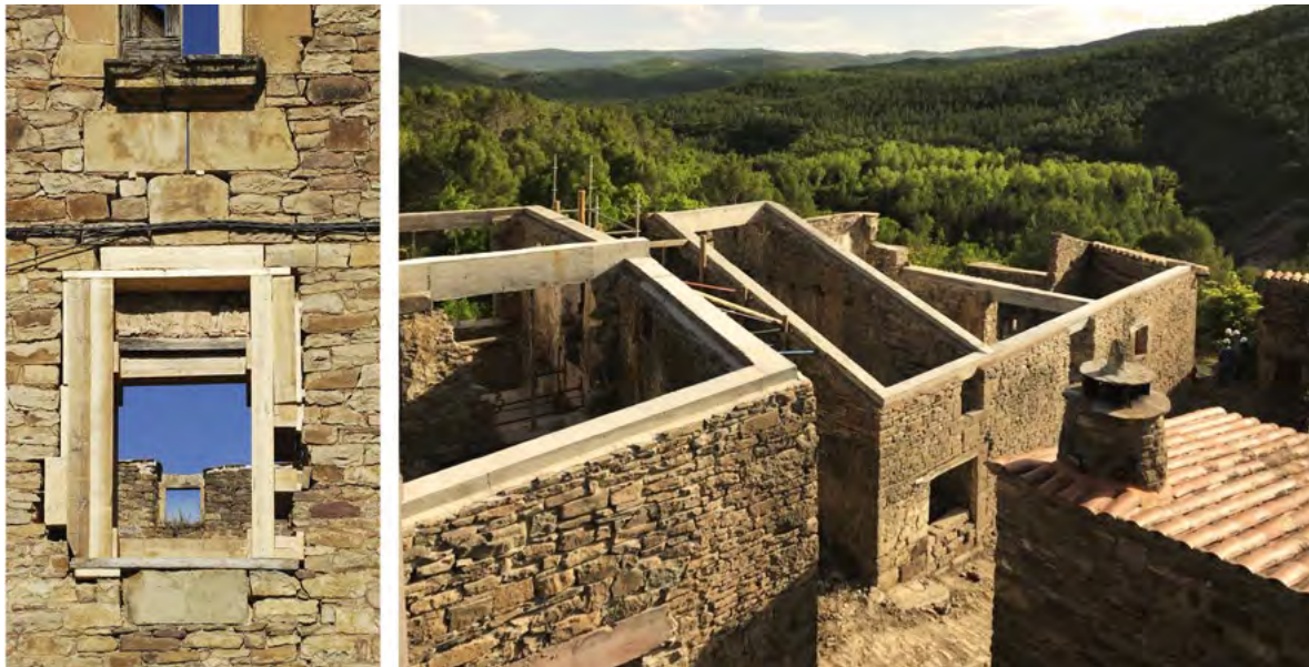
Figura 15. Ruesta. Lavori iniziati nel 2019 per il consolidamento degli edifici lungo il Camino di Santiago (foto ©Sergio Sebastián Architects, 2019).
