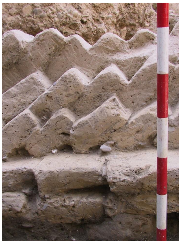
Ilustración 21. Detalle de la cubierta de adobe tumba 70 (foto cedida por M a Pilar Galve)
