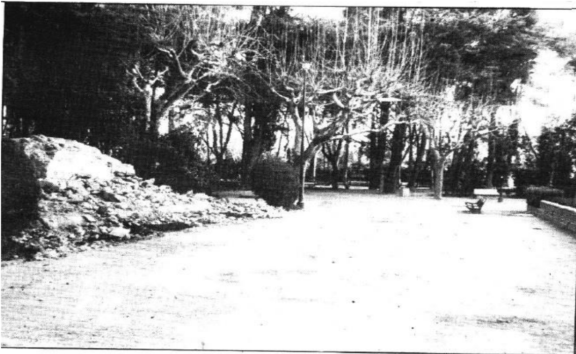
Ilustración 55. Estado en que quedó la Cruz de los Caídos del Parque Miguel Servet de Huesca
